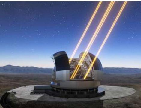
El ELT es un telescopio reflectante totalmente orientable. El diseño incluye un espejo primario segmentado que mide 39,3 metros de diámetro, un espejo secundario de 4,2 metros de diámetro y un espejo terciario con un diámetro de 3,75 metros.
